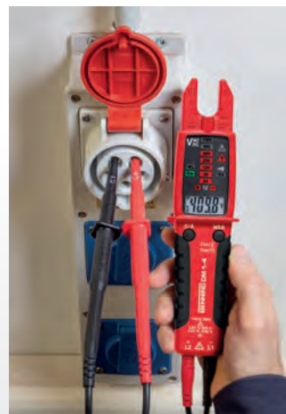
Spannungsmessung und Drehfeldrichtungsprüfung
